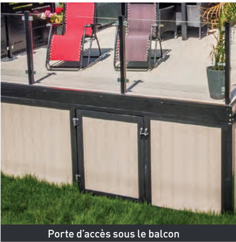
Porte d'accès sous le balcon
