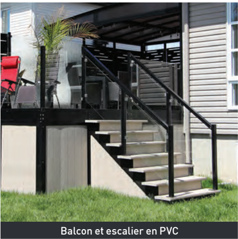
Balcon et escalier en PVC
